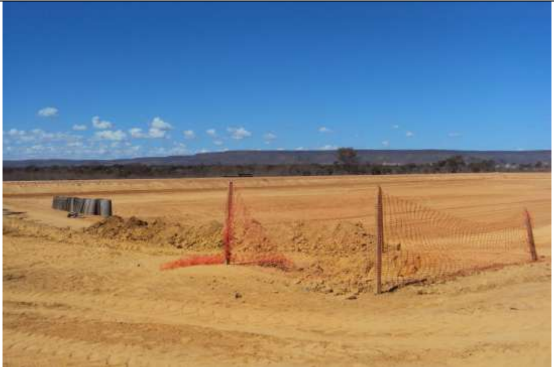
FOTO 21: : estação de tratamento de esgoto em construção
