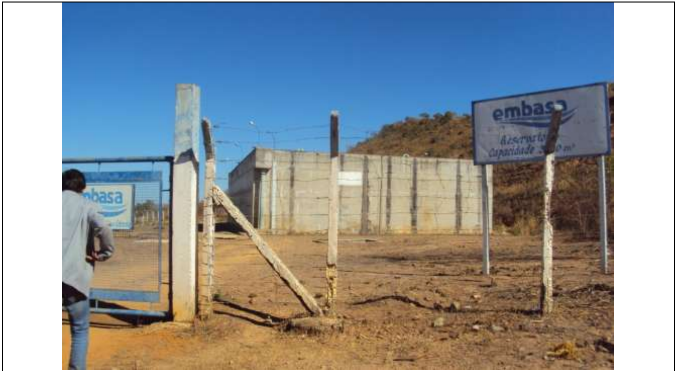
FOTO 17: Reservatório secundário – cercado e sinalizado
