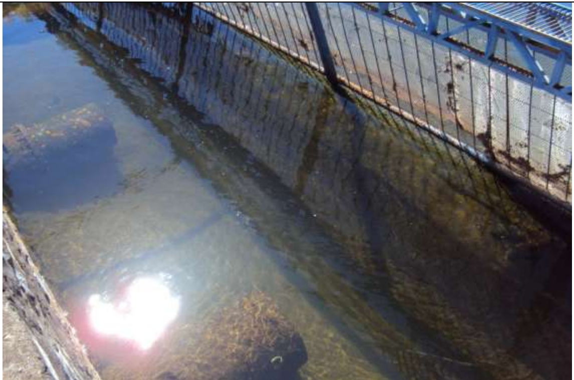
FOTO 06: Entroncamento da captação – água em boas condições
