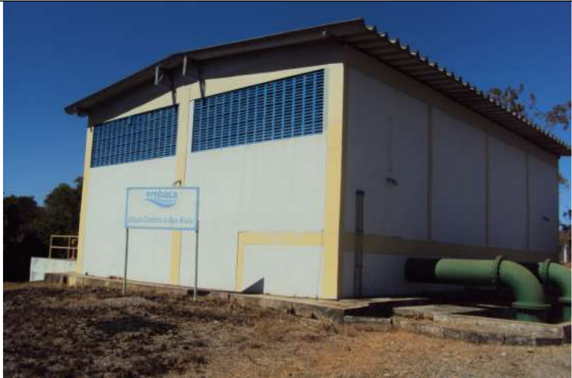
FOTO 09: estação elevatória de água bruta
