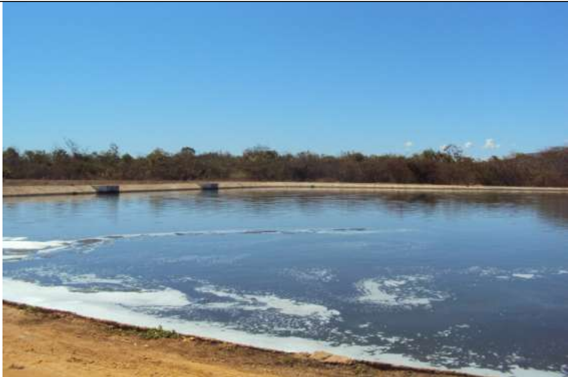
FOTO 20: : estação de tratamento de esgoto em operação
