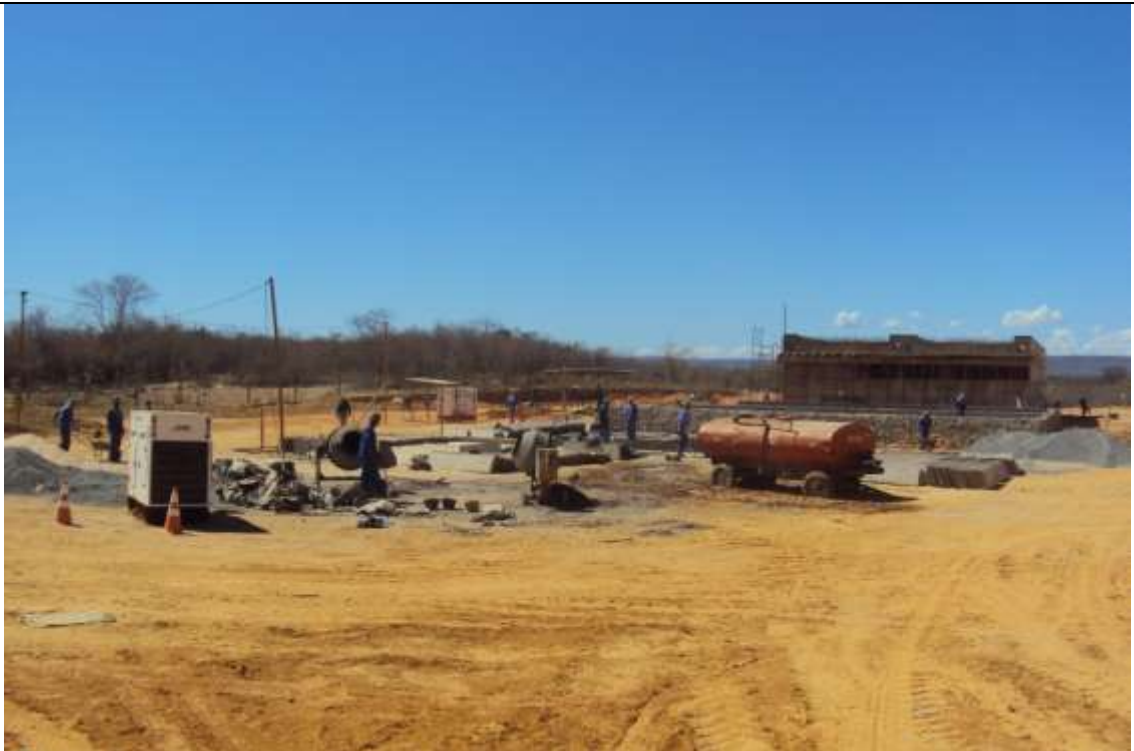
FOTO 22: estação de tratamento de esgoto em construção
