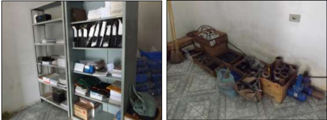
Figura 7: Área interna necessitando de adequações.
