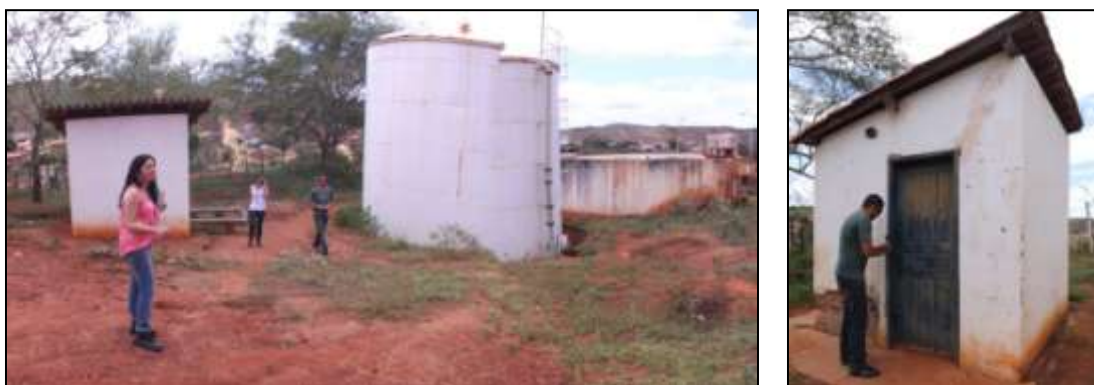
Figura 12: Ausência de sinalização das unidades.
