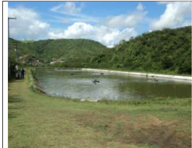
Figura 7.2 – Vista da Lagoa Aerada da ETE que atende Cachoeria e São Félix
