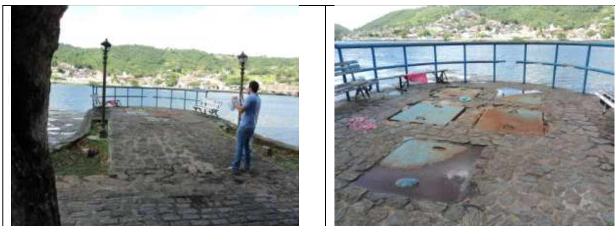
Figura 9.4 – Vista da EEE 04
