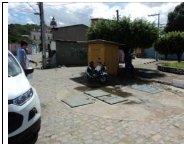
Figura 9.3 – Vista da EEE-03
