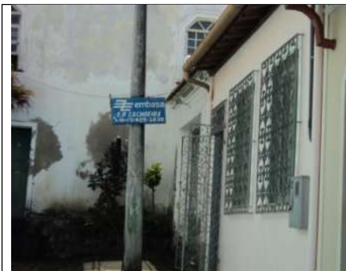
Figura 6.2 – Vista do Escritório Local da EMBASA em Cachoeira
