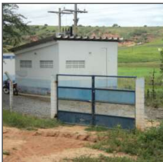
Figura 12: Portão sem sinalização na área do Poço da Lagoa Vermelha.
