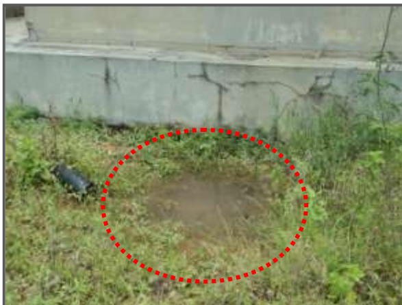
Figura 23: Reservatório com infiltração (Lagoa Vermelha). Subaproveitamento da capacidade. Rachaduras, vazamentos e empoçamento na área do reservatório de Lagoa Vermelha.
