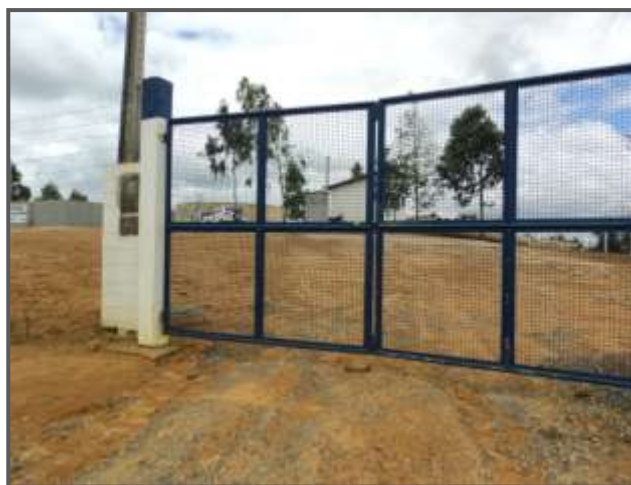
Figura 22: Portão sem sinalização indicando acesso restrito.
