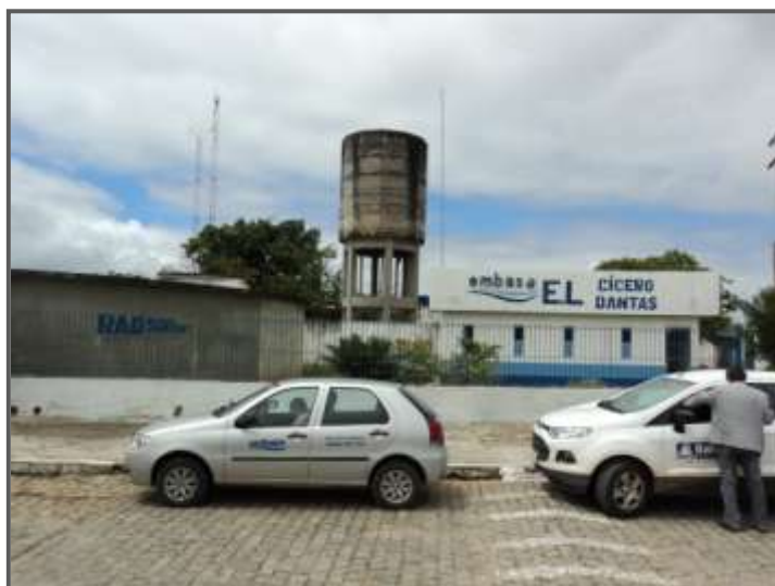
Figura 6: Reservatórios apoiado e elevado com capacidades, respectivamente, 500m 3 e 100m 3 (à esquerda), e reservatório com capacidade 100m 3 (à direita).
