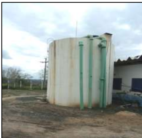
Figura 13 – Ausência de guarda corpo na escada e laje de cobertura
