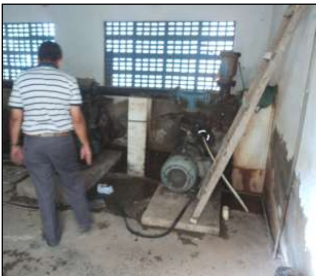
Figura 11- Interior da casa de bombas em mau estado de conservação
