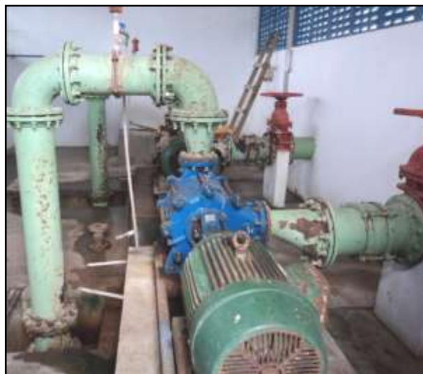
Figura 11- Interior da casa de bombas em mau estado de conservação
