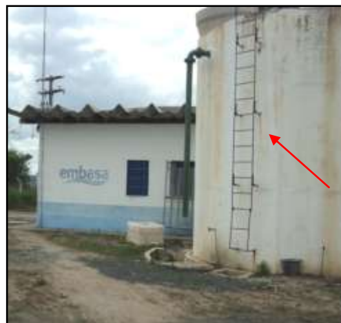
Figura 13 – Ausência de guarda corpo na escada e laje de cobertura
