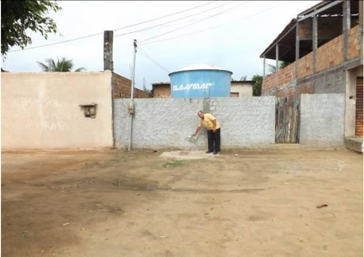
FOTO 02: Reservatório Comunitário Sem Água
