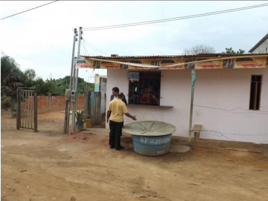
FOTO 04: Reservatório Individual de Água
