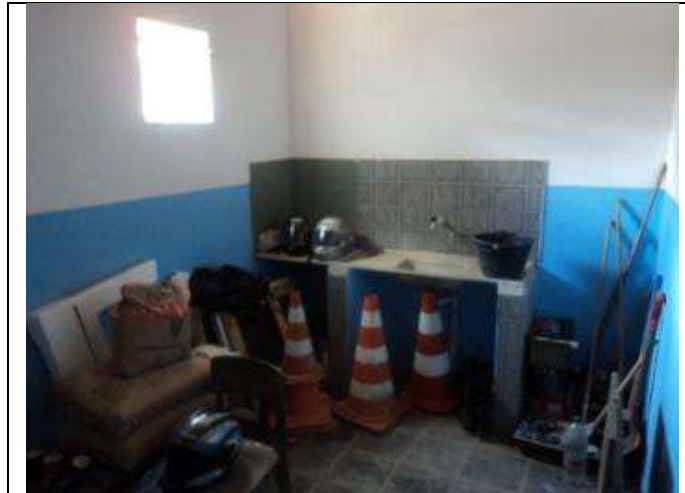
Figura 8.12 – Materiais dispostos de forma e em local inadequados
