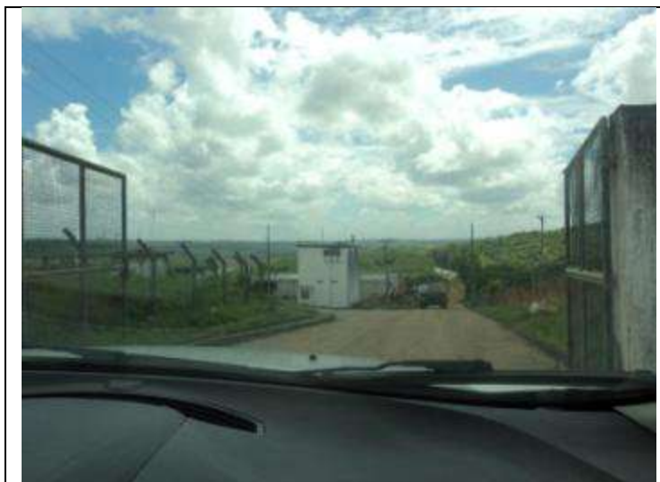
Figura 8.2 – Ausência de sinalização na área da ETA
