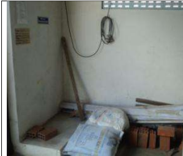
Figura 8.4 – Fluossilicato de sódio e materiais diversos mal acondicionados
