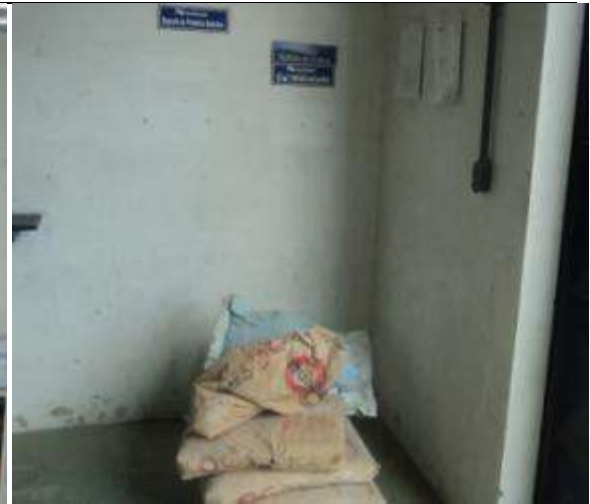
Figura 8.5 – Cal hidratada acondicionada diretamente sobre o chão, sem a presença de estrado.
