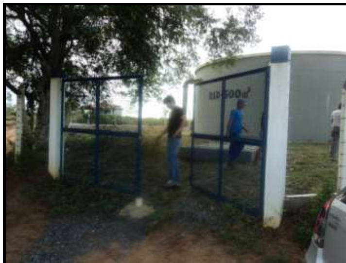
Figura 13 – Reservatório do SAA águas do Sertão sem a devida sinalização
