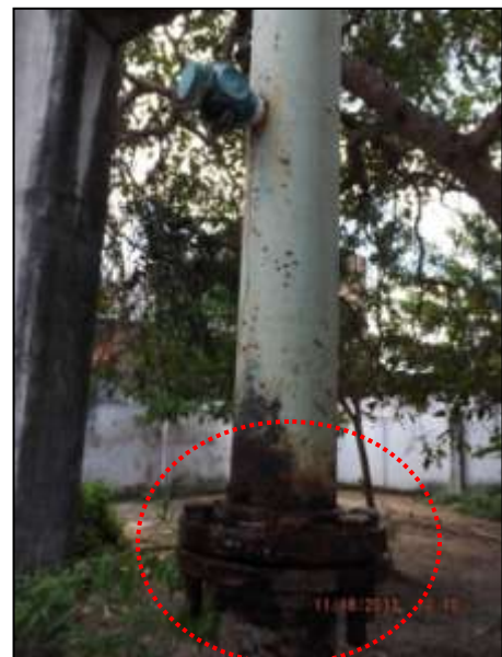
Figura 15: Vazamentos na caixa de registro e na tubulação do REL
