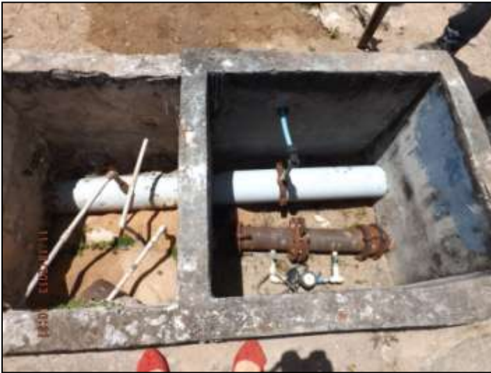
Figura 14: Caixas de inspeção
