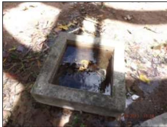
Figura 15: Vazamentos na caixa de registro e na tubulação do REL
