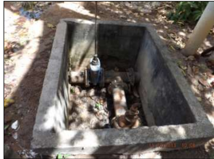
Figura 14: Caixas de inspeção
