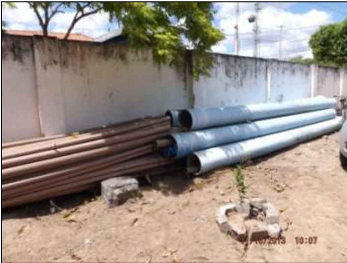
Figura 12: Acúmulo de materiais expostos à degradação físico-química e biológica.
