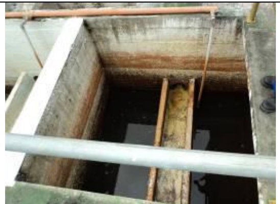
Fig. 6.11 – Filtro em manutenção
