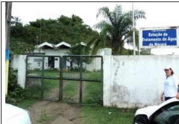
Fig. 6.4 – Entrada da ETA isolada e sinalizada
