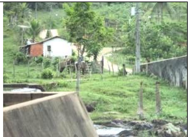
Fig. 6.2 – Portão que dá acesso à área da barragem no ponto de captação
