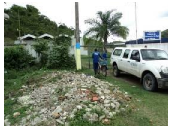
Fig. 6.5 – presença de entulho e mato junto ao portão da ETA
