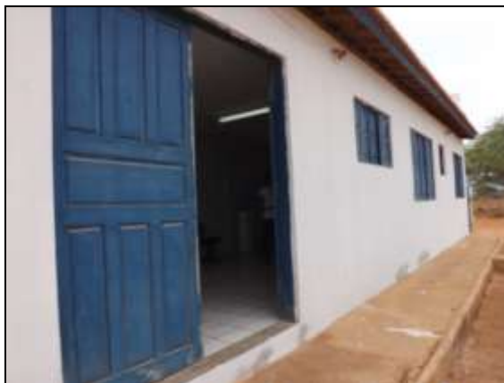
Figura 14: Ausência de interligação com o sistema corporativo.
