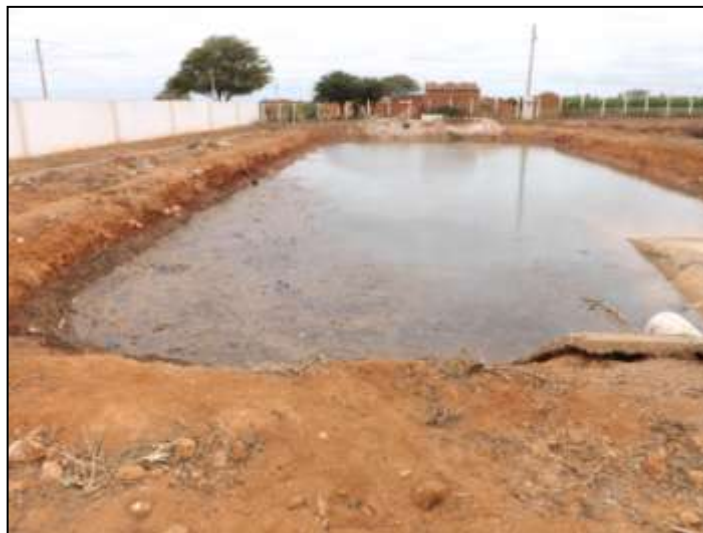
Figura 12: Lançamento de rejeito salino de forma inadequada no ambiente
