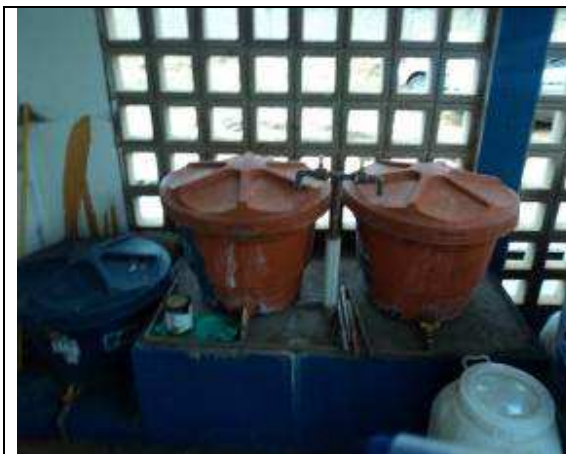
Figura 7.7 – Tinas dosadoras necessitando de melhor organização e limpeza
