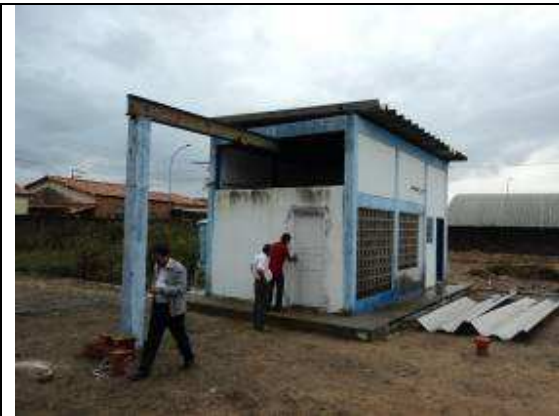
Figura 7.5 – Unidade de Tratamento sem sinalização
