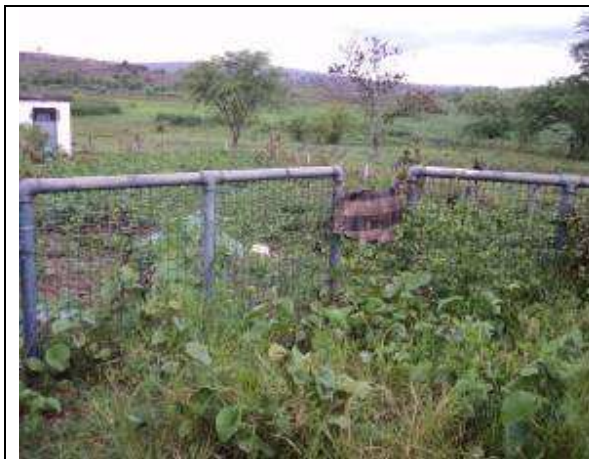
Figura 7.3- Portão de acesso do Poço 03 em estado precário e sem sinalização
