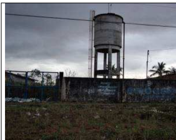
Figura 7.12 – Ausência de sinalização na entrada do REL 01
