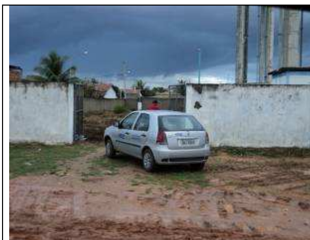
Figura 7.9 – Vista da entrada do REL 02 (300 m 3 )
