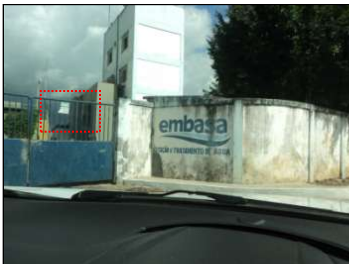
Figura 2: Placa de sinalização danificada.
