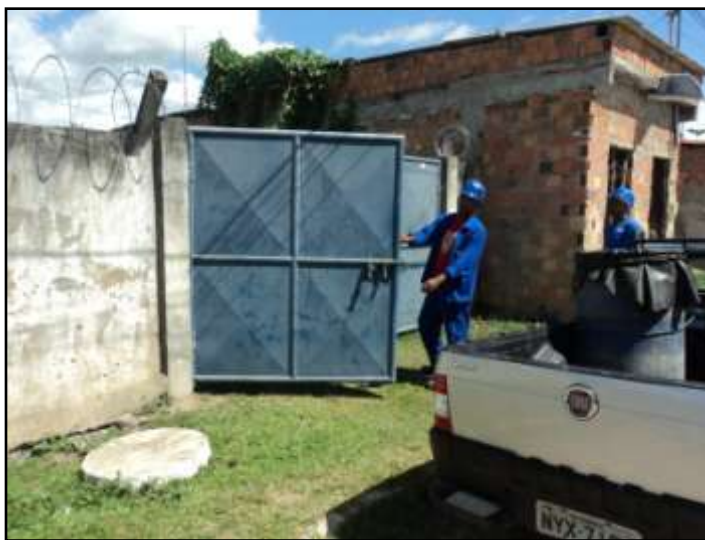
Figura 10: EEG sem sinalização e acesso restrito.
