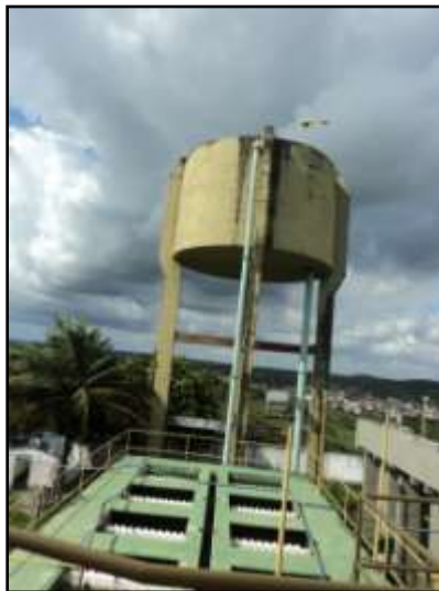
Figura 3: REL sem sinalização, guarda corpo e para raios.
