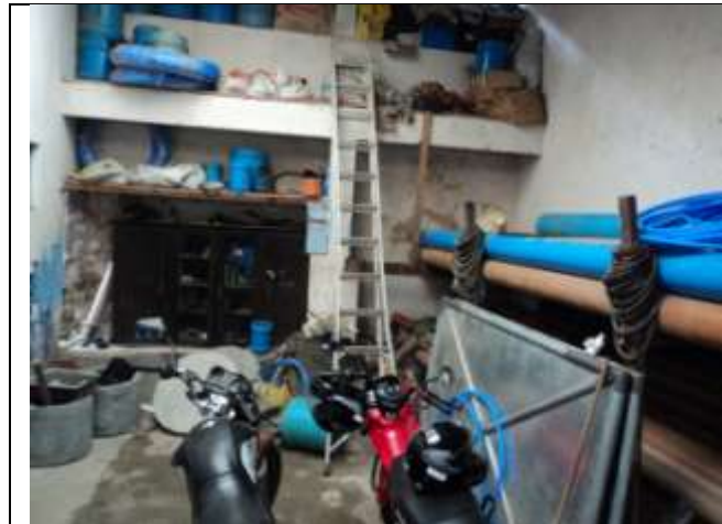
Figura 8.11 – Armazenamento de peças e materiais de forma inadequada
