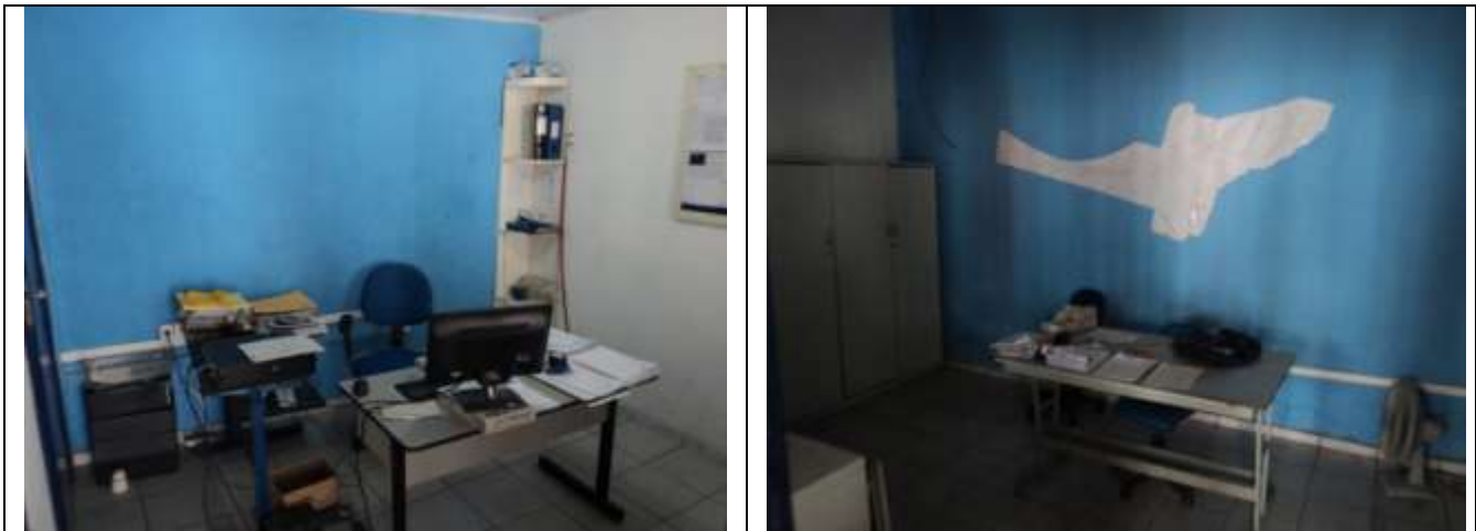
Figura 8.12 – Salas mal-iluminadas e mal-equipadas
