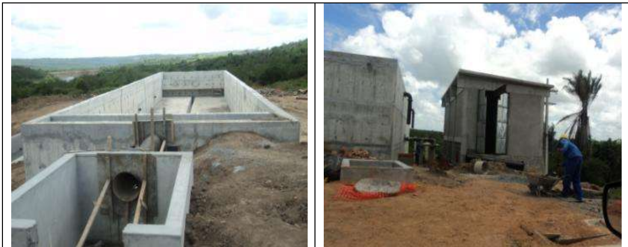
Figura 6.1 – Obras de expansão do SIAA de Muritiba
