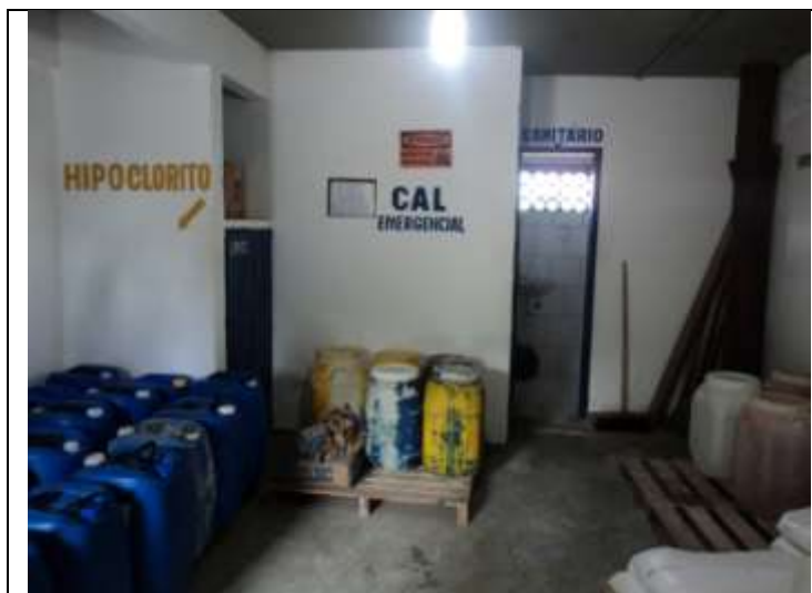
Figura 6.5 – Local de armazenamento de produtos químicos
