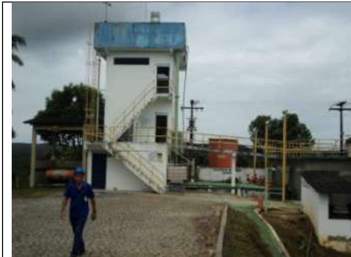
Figura 6.2 – Vista da ETA de Saubara
