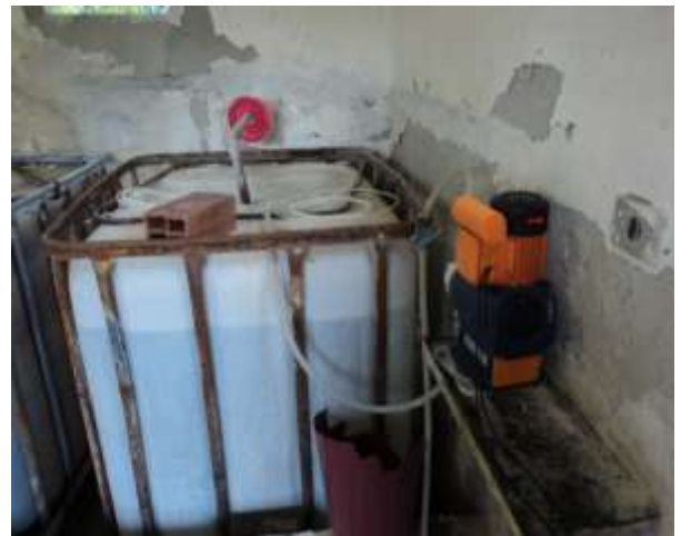
Figura 8.4 – Casa de cloração e bombas dosadoras do Poço 08
