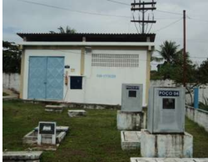
Figura 6.1 – Chegada de água bruta dos poços 04 e 07
