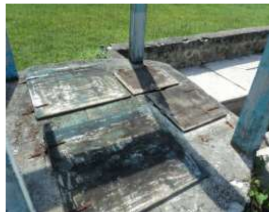
Figura 9.3 – Poços de visita da EEE-06 (à direita) e da EEE-01 (à esquerda) sem cadeados
