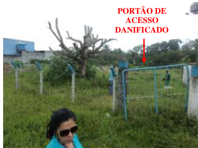
Figura 8.2 – Vista da área do Poço 07
