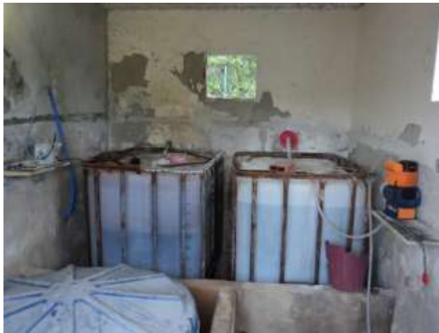
Figura 8.4 – Casa de cloração e bombas dosadoras do Poço 08
