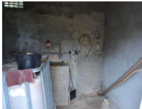
Figura 8.5 – Casa de cloração e bombas dosadoras do Poço 10
