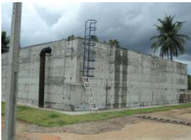
Figura 6.4 – 01 dos reservatórios de 1.500 m 3
