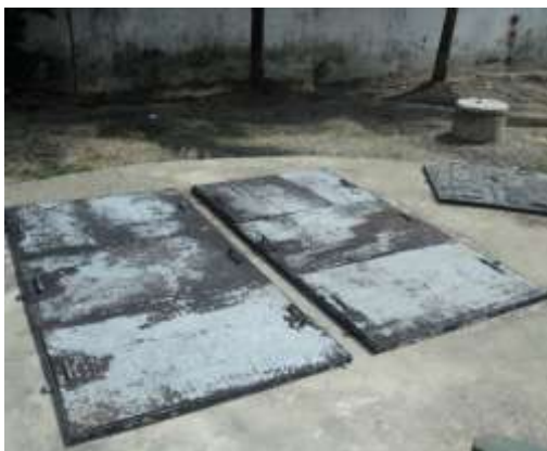
Figura 9.3 – Poços de visita da EEE-06 (à direita) e da EEE-01 (à esquerda) sem cadeados
