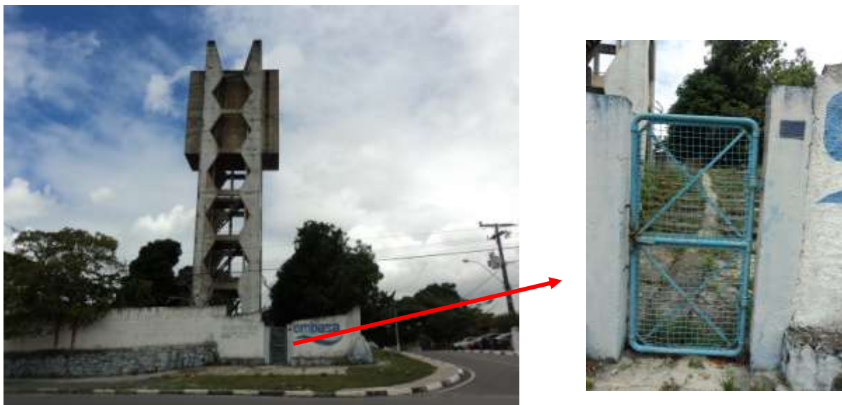
Figura 8.11 – Porta de Acesso do REL 400 m 3
