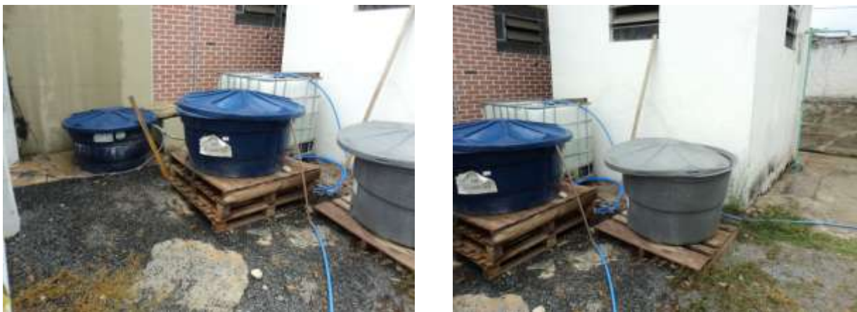
Figura 8.10 – Tinas dispostas em local inadequado
