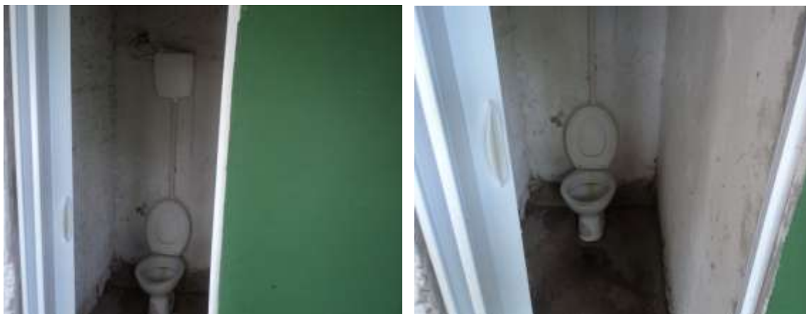
Figura 9.5 – Banheiro em condições precárias
