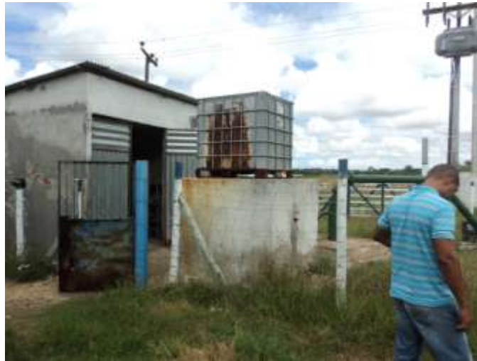
Figura 8.3 – Vista da área do Poço 10
