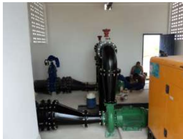
Figura 6.5 – Vista da EEAT construída
