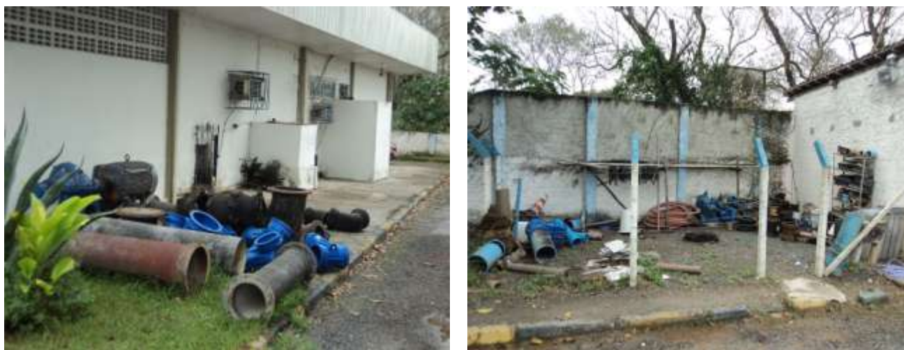
Figura 8.9 – Materiais diversos dispostos em locais inadequados
