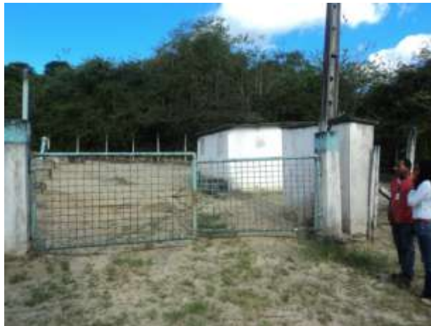
Figura 8.3 – Portão de acesso ao Poço 09
