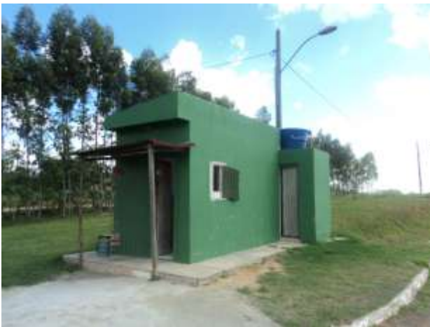
Figura 7.3 - Casa do Operador
