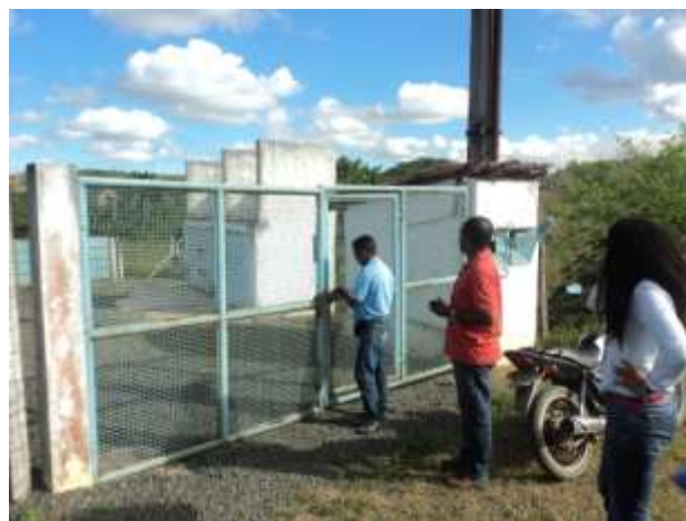
Figura 8.2 – Portão de acesso ao Poço 06
