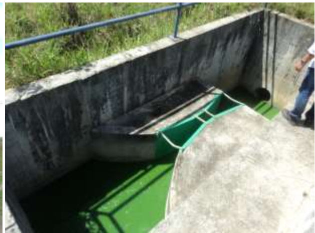
Figura 7.4 – Vista da Calha Parshall
