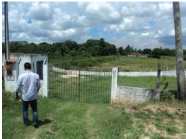
Figura 9.3 – Vista do portão de acesso da EEE - I
