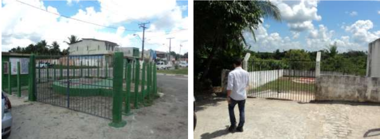
Figura 9.2 – Vista do portão de acesso da EEE- G (à direita) e do portão de acesso da EEE- F (à esquerda)
