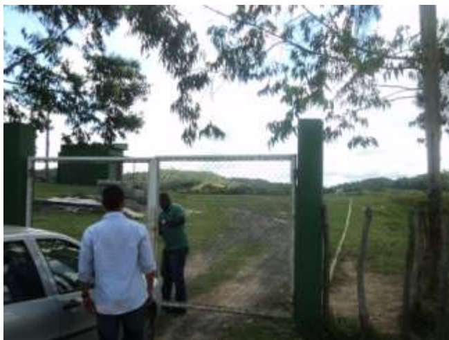
Figura 9.6 – Ausência de sinalização na ETE DE Mata de São João – Sede
