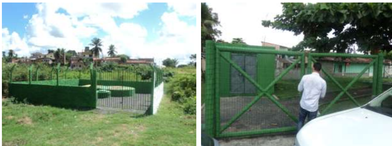
Figura 9.1 – Vista do portão de acesso da EEE- H 2 (à direita) e do portão de acesso da EEE-H 1 (à esquerda)
