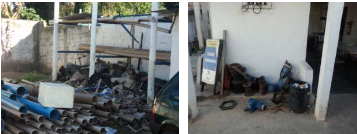
Figura 8.9 – Materiais dispostos de maneira inadequada
