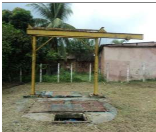
Figura 23 - Estrutura metálica para içamento de bombas da EEE Simões Filho
