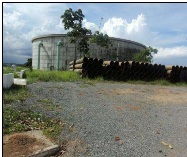
Figura 3 - Reservatório de Simões Filho
