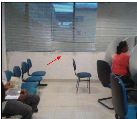
Figura 17 - Loja de Atendimento apresentando infiltrações nas paredes
