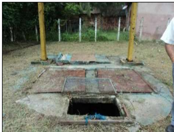
Figura 24 - Laje de cobertura do poço de sucção da EEE Simões Filho
