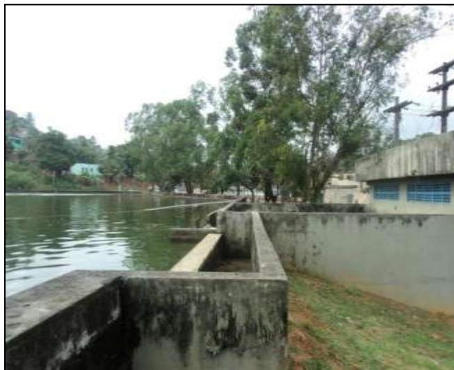
Figura 28 - Muro do dique de contenção da lagoa aerada
