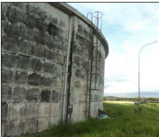
Figura 10 - Reservatório de Simões Filho com guarda-corpo enferrujado
