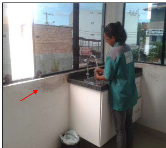
Figura 17 - Loja de Atendimento apresentando infiltrações nas paredes
