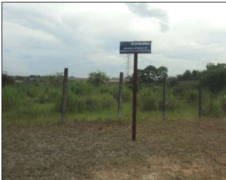
Figura 30 – Placa de identificação da ETE Vila Serena danificada
